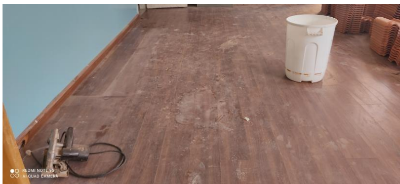
Foto 06 – Sala / próximo ao depósito
