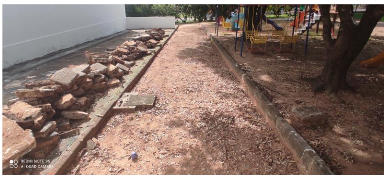
Foto 08 - Cobertura – não iniciada.
